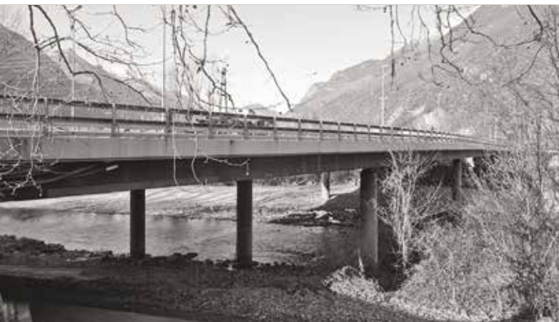
1. Presso lo svincolo autostradale di Bellinzona Nord, il ponte in cls armato precompresso sopra il fiume Moesa (fine anni Sessanta)
