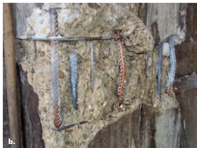
Fig. 1 Formazione di cerniera plastica in pilastri di edifici produttivi: (a) autorimessa FIAT sita a Pile; (b) edificio adibito ad allevamento bovino sito a Fossa.
