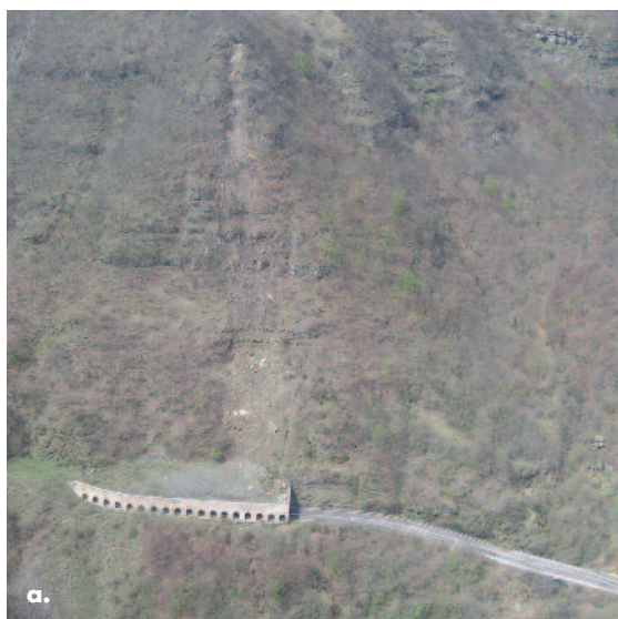
Fig. 1 (a) La SS80 "del Gran Sasso d'Italia" interessata da caduta massi, protetta da galleria paramassi fenestrate. (b) Distribuzione percentuale delle soluzioni adottate per la gestione del traffico temporaneo nelle 61 tratte stradale per le quali sono state registrate problematiche (dati aggiornati al 01/05/09).
