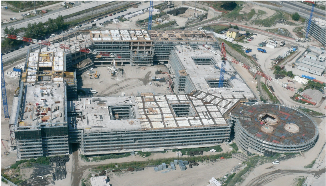
Fig. 7 - The construction site of the Ospedale del Mare.
