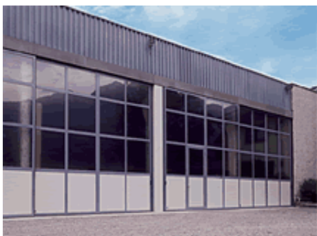
Fig.4-Portoni industriali di tipo scorrevole e incernierato.
