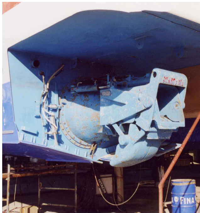
Figura 4 – anodi sacrificali di zinco sui meccanismi dell'idrogetto
